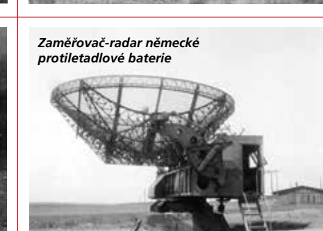
Zaměřovač-radar německé protiletadlové baterie
